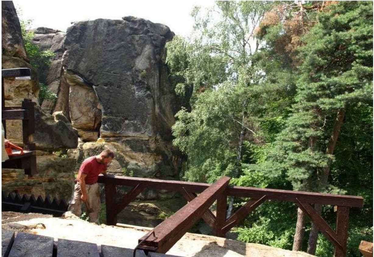
opravy podlah – Rotštejn červen 2008
